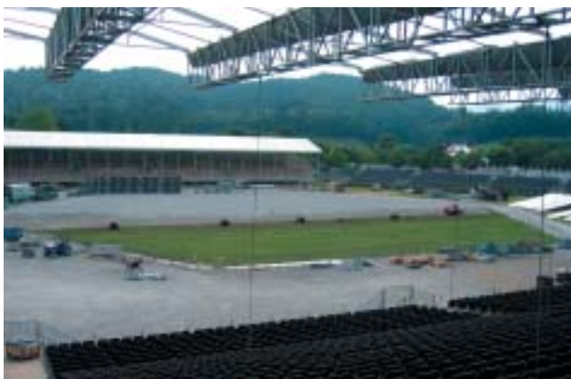
Die filigrane Haupttribüne nimmt Formen an
