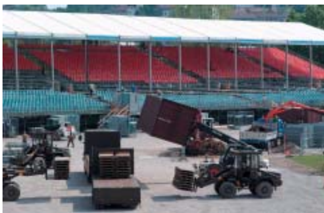
Unzählige Tonnen Material wurden angeliefert...
