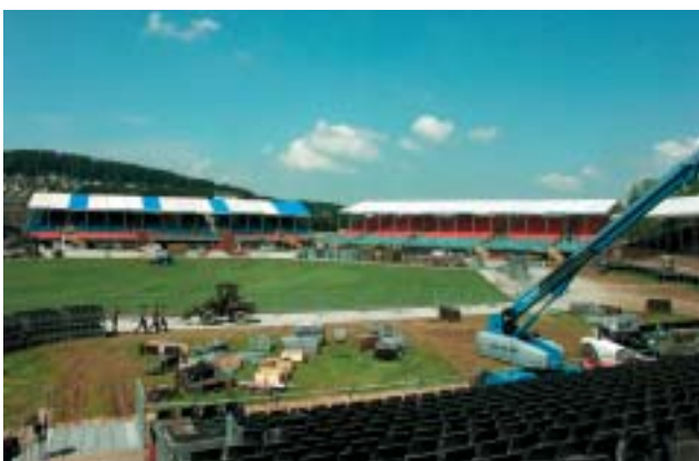
Tag für Tag konnte der Baufortschritt bestaunt werden
